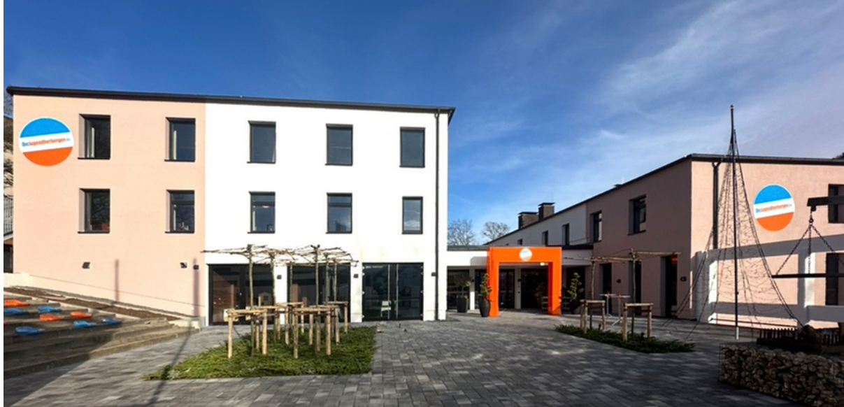
Frontansicht mit Eingangsbereich | ©@diejugendherbergen.de
