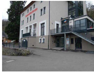
Nebeneingang im UG
