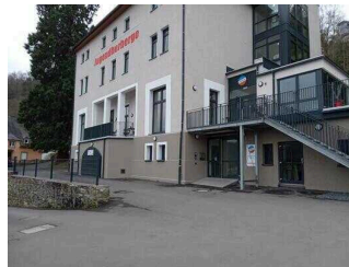
Haupteingang im EG
