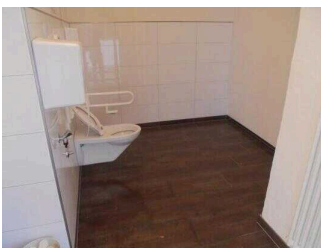
WC im Außenbereich (Vorplatz)
