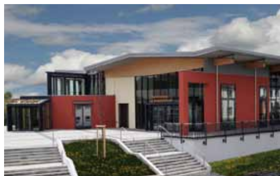
Die Jugendherberge Prüm verfügt über ein großes Kongresszentrum sowie ein eigenes Restaurant.
